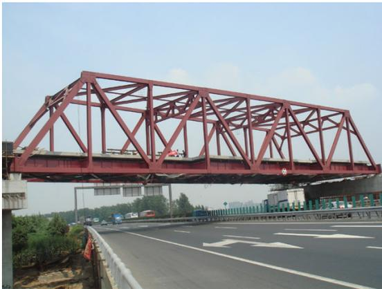
图 5 有风撑桁架桥
