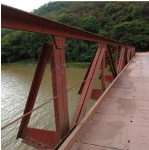
图 10 胜备桥主桁架防侧向失稳构造
